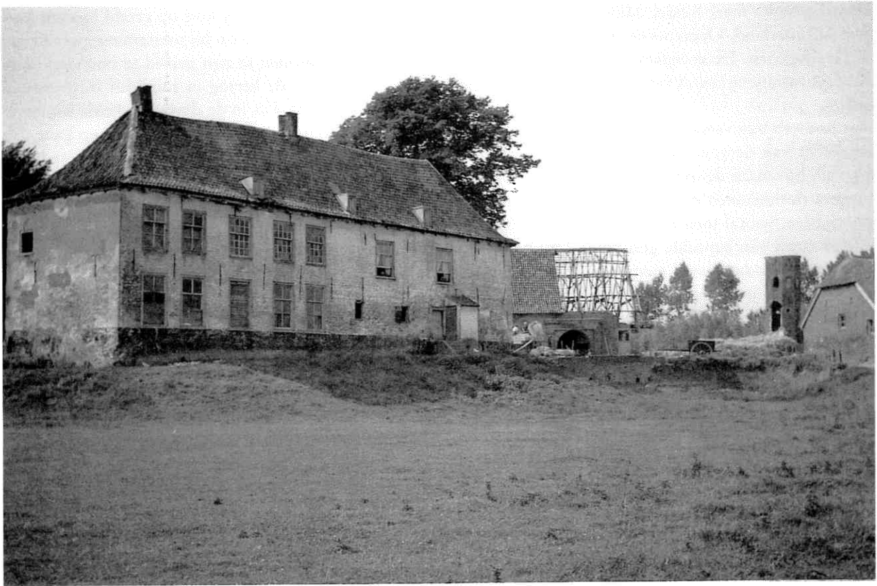
Het Huis Oyen in de zomer van 1948. De oorlogsschade is nog niet hersteld. N.B. Het huis staat op een ophoging in verband met hoge waterstanden. Foto D.J.G. Buurman.
